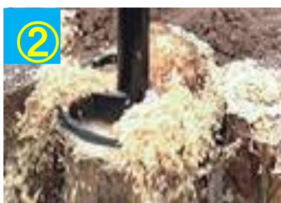
② バックホーを操作し、切削
