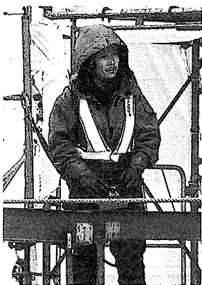
無線操作盤を使い目視で確認しながら吊り上げを行う作業員
